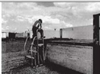
墜落・転落防止：昇降台の導入
