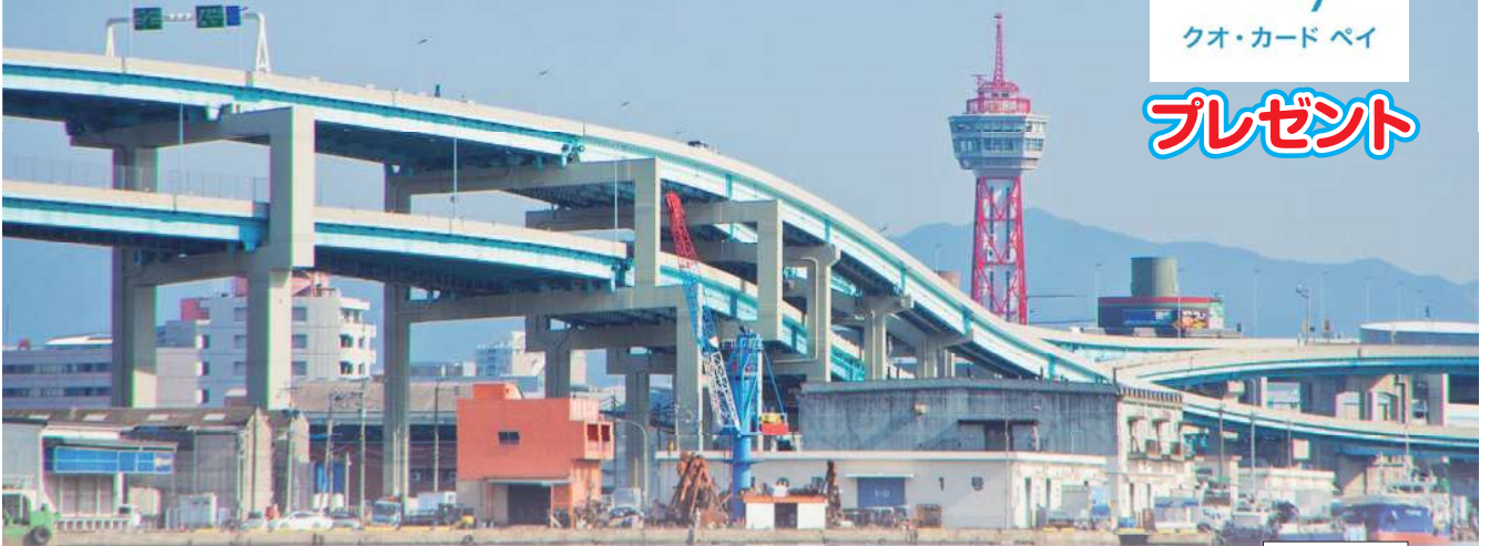
福岡高速環状線 天神北出入口付近
